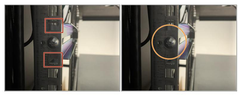
Schieben sie die Schiene von der Innenseite des Racks gegen den Träger, so dass die beiden Winkel sich im Rack abstützen und das Schraubloch mittig sitzt
